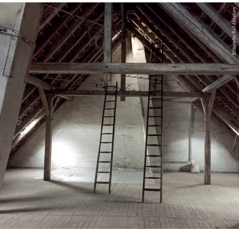
Abb. 4: Brandmauer und Holzbalkendecke im Bestand
